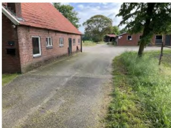
Figuur 8: Overzichtsfoto bebouwing
