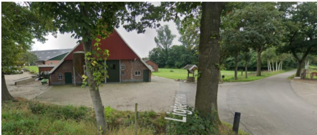
De nieuwe woning is volledig omgeven door erfverharding.
