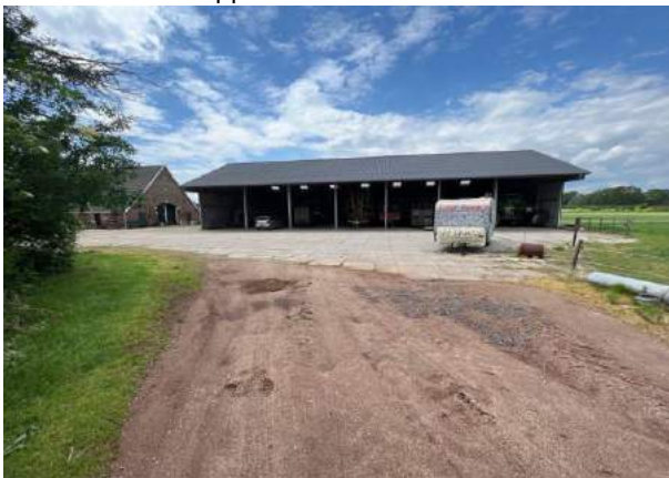
Figuur 11: Overzichtsfoto puinverharding
