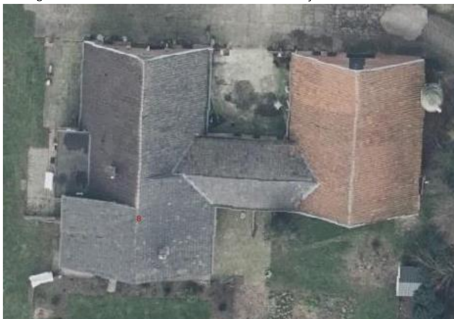
Figuur 4 bestaande woning
