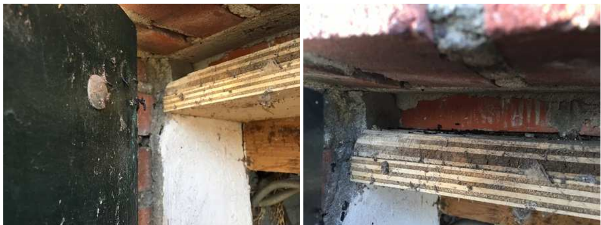
Detailopnames van de zomerverblijfplaats van de gewone dwergvleermuis in de ligboxenstal. Één van de verblijfplaatsen van de gewone dwergvleermuis in/aan de ligboxenstal.
