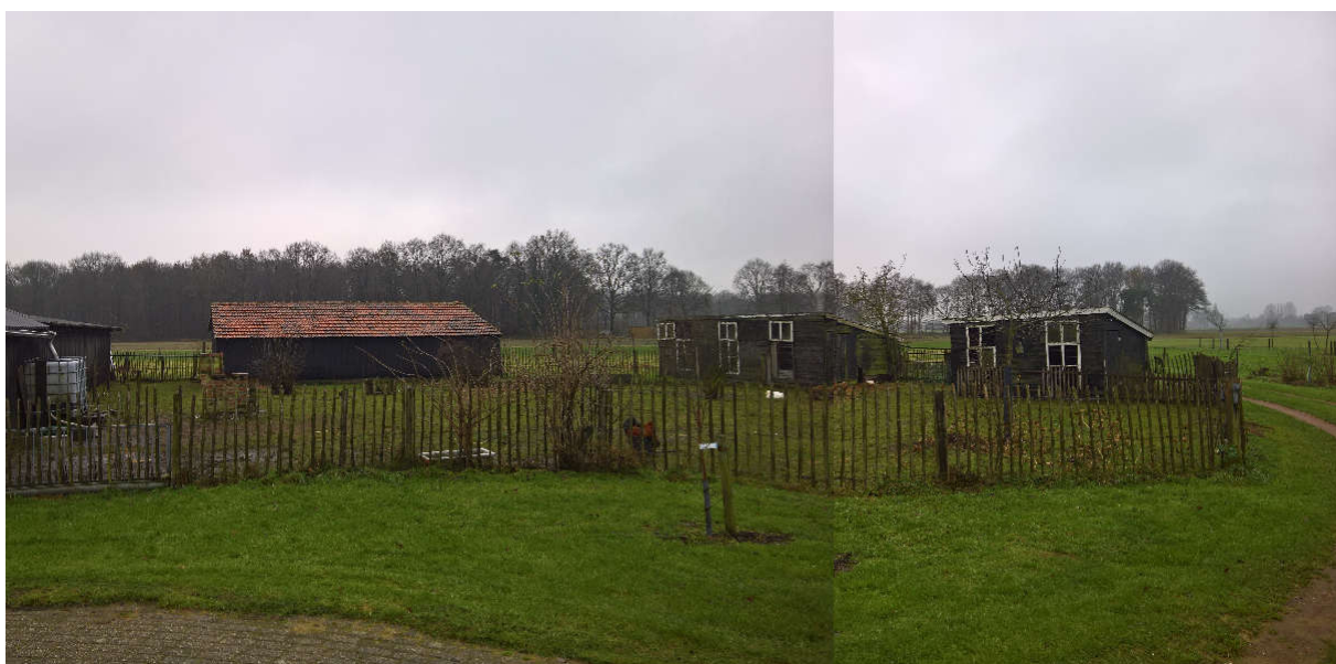
Te slopen bebouwing
