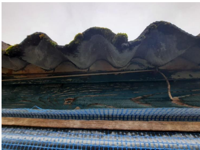
Figuur 5.2: ruimte onder de golfplaten dicht getimmerd
