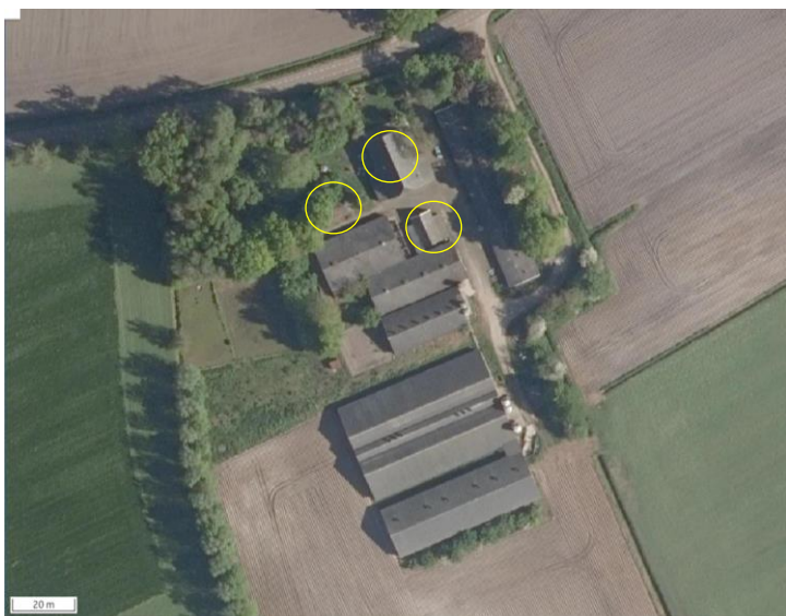
Luchtfoto van het plangebied. De te handhaven gebouwen worden met een cirkel aangeduid. Alle overige bebouwing zal gesloopt worden.
