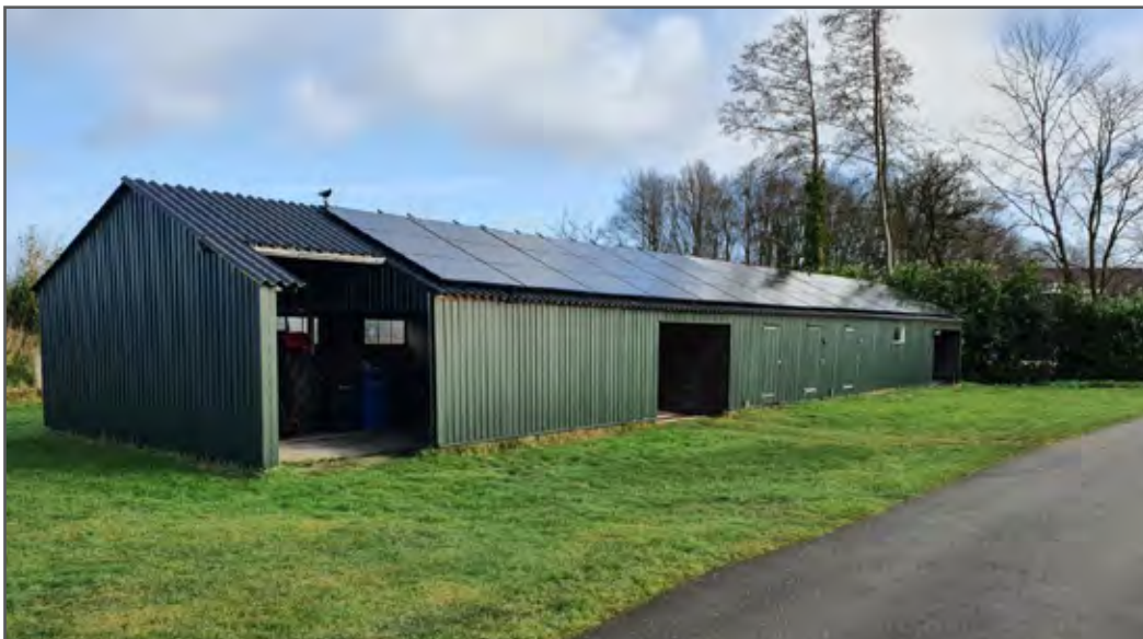
Foto: het te behouden bijgebouw
