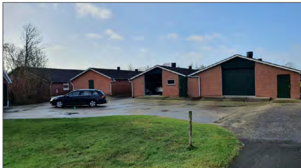
Foto: de te slopen schuren, een deel van de rechter schuur blijft behouden
