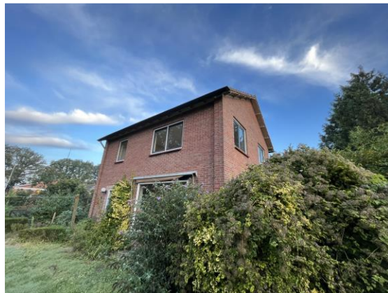
De daklijst van de woning op het erf sluit niet nauw aan op de buitengevel en biedt vleermuizen de mogelijkheid om de sponwmuur van het huis te bereiken.
