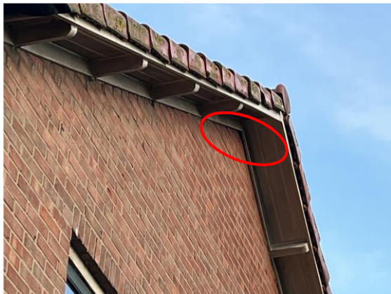
De daklijst van de woning op het erf sluit niet nauw aan op de buitengevel en biedt vleermuizen de mogelijkheid om de sponwmuur van het huis te bereiken.
