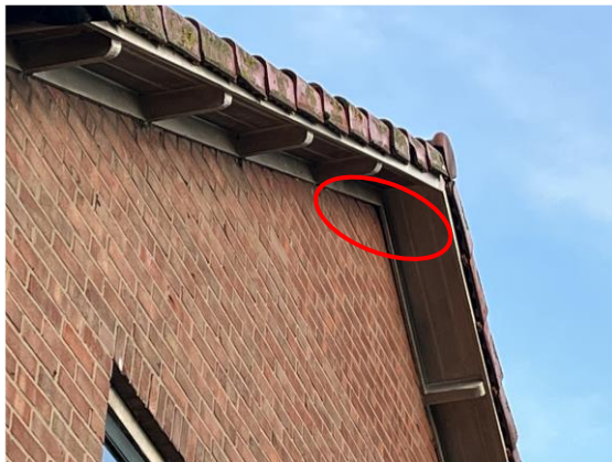
De daklijst van de woning op het erf sluit niet nauw aan op de buitengevel en biedt vleermuizen de mogelijkheid om de spouwmuur van het huis te bereiken.
