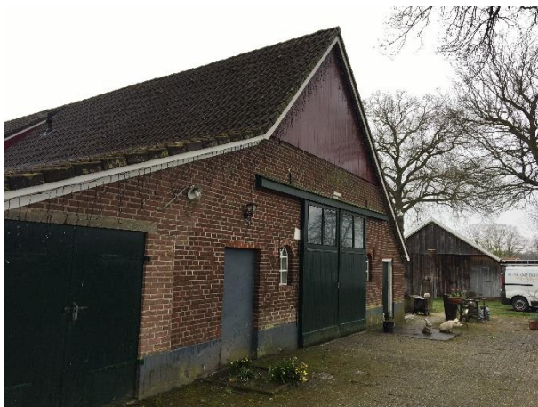
Aanzicht op de als woning te verbouwen deel.
