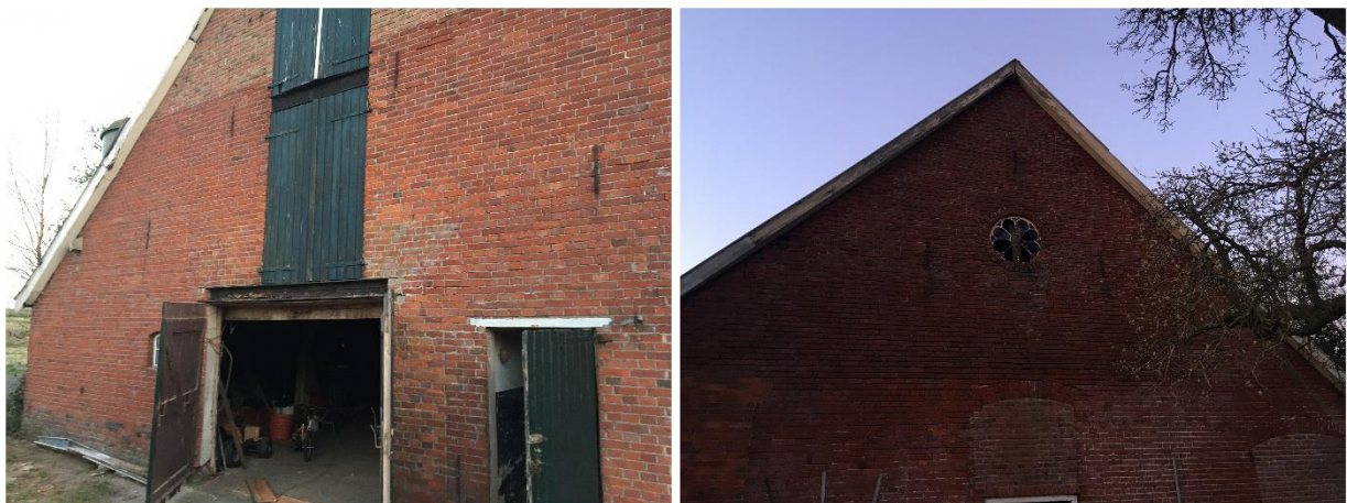
Aanzicht op de als woning te verbouwen schuur. Links voorzijde, rechts achterzijde.
