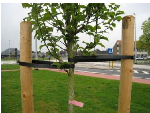
Voorbeeld van een jonge boom, voorzien van twee boompalen en boomband.
