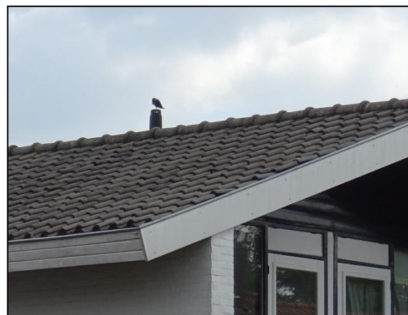
Figuur 10. Schuine dakpannen aan achtergevel.
