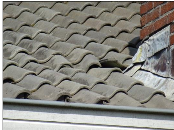
Figuur 11. Schuine dakpan naast schoorsteen.
