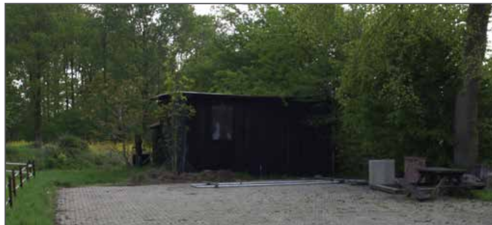
Afbeelding: Oorspronkelijke schuur
