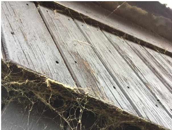
Er zijn geen kieren vastgesteld achter de houtbetimmering.
