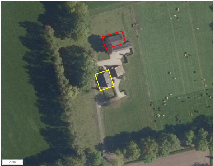
Luchtfoto van het erf met daarop aangegeven de twee woningen (gele contour) en de te slopen varkensstal (rode contour).
