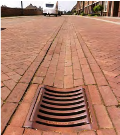
Brede molgoot; zichtbaar afvoeren van regenwater
