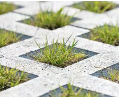
● Parkeerplaatsen en opritten; waterdoorlatende open verharding, zoals grasbetonstenen of -keien. Bij de opritten is het middelste deel gesloten ten behoeve van de toegankelijkheid.
