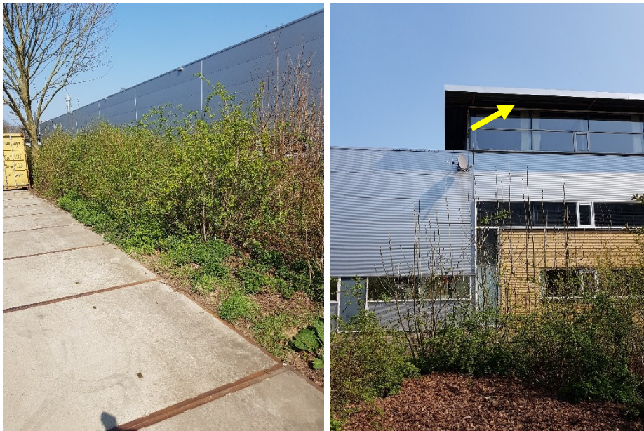
Figuur 10. De bosschages die deel uitmaken van het functioneel leefgebied van de huismus (links) en het gebouw van Rusink Catering V.O.F. waar huismussen onder de dakrand broeden (rechts; gele pijl geeft de dakrand aan).
