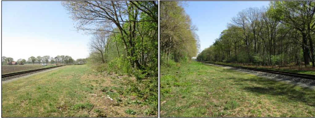
Figuur 5 De waarneming uit 2019 is bekend vanuit de noordzijde van de spoorlijn (zonnige berm, links). Op de rechterfoto zijn aan de overzijde van de spoorlijn de te kappen bomen te zien, benodigd om de geasfalteerde weg te realiseren.
