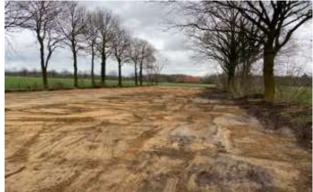
Figuur 16: Reeds gesloopte schuur
