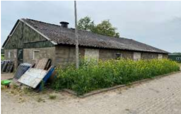
Figuur 13: Aanwezige onverharde afwateringzone
