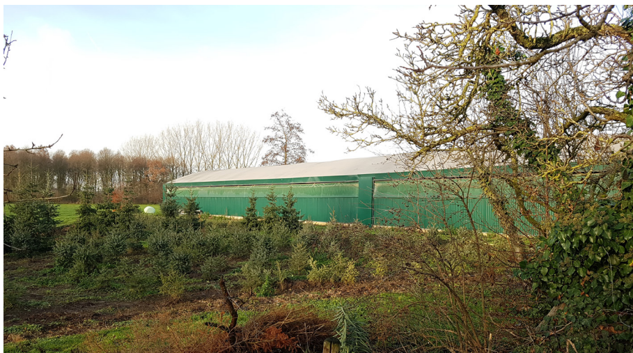
Te saneren pluimveestal.
