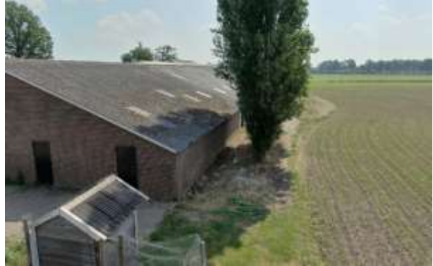
Figuur 14: Aanwezige onverharde afwateringzone
