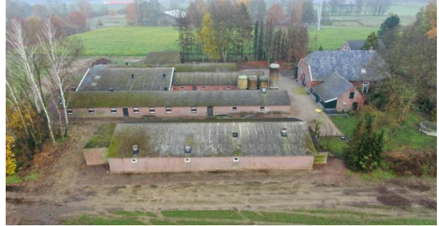
Figuur 12: Overzichtsfoto asbestdaken
