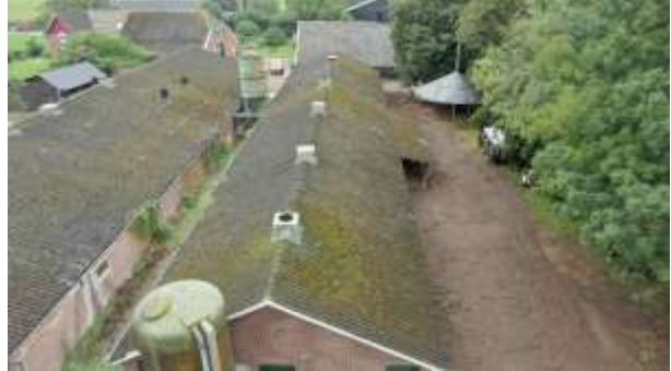
Figuur 14: Aanwezige onverharde afwateringzone
