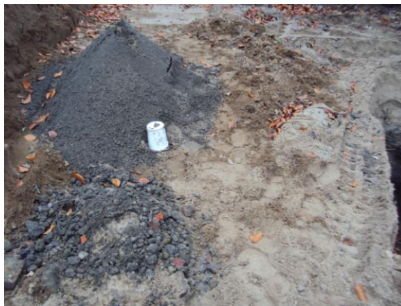
Foto: Opgegraven en gezeefd materiaal sleuf 01
