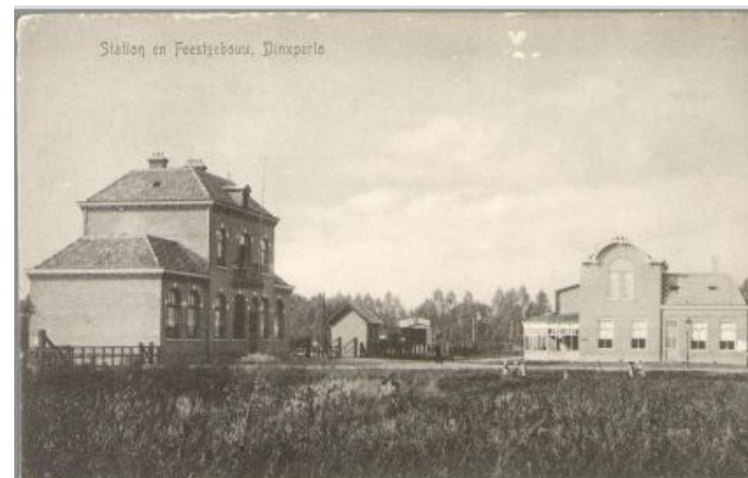
Het station van Dinxperlo (links) en het restaurant-feestgebouw van Boland, circa 1905-1910 (bron: gelderlandinbeeld.nl )
