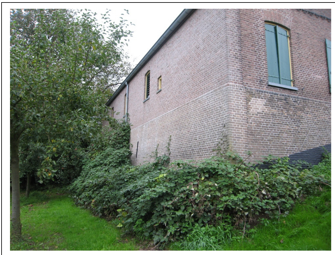
Foto 2. Achterzijde gebouw Aerdsedijk 49
