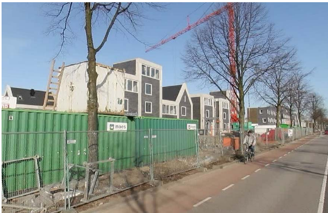
Mozartlaan tijdens de bouwwerkzaamheden
