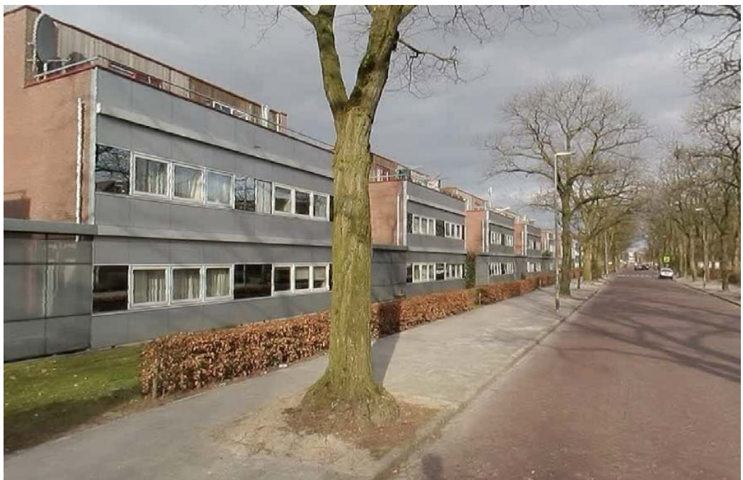
Patiowoningen aan de Bachlaan
