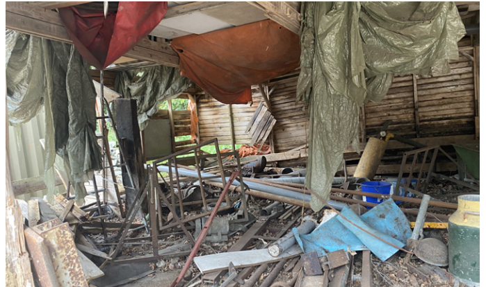
Afbeelding 3. Binnenzijde te amoveren schuur
