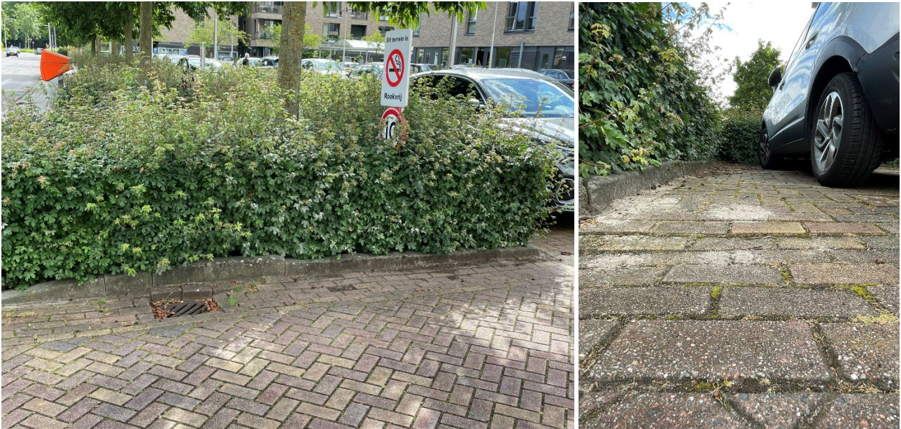
Figuur 14: zichtbare wortelopdruk in band en bestrating bij de Kaukasische Elzen 2 t/m 12
