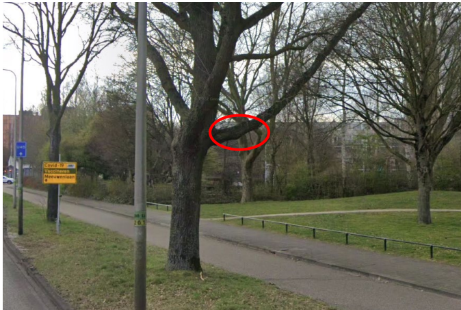
Figuur 18: te snoeien zijtak (bron: google streetview)
