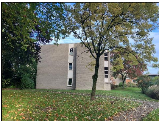
Figuur 2.9 (rechts): Zuidzijde gebouw 2.
