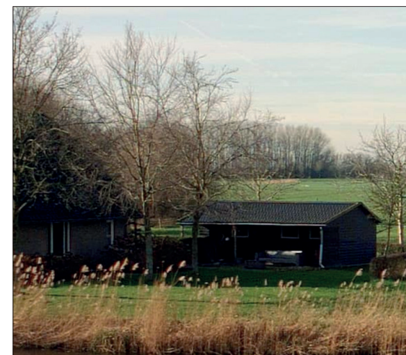
kleine garage wordt gesloopt
