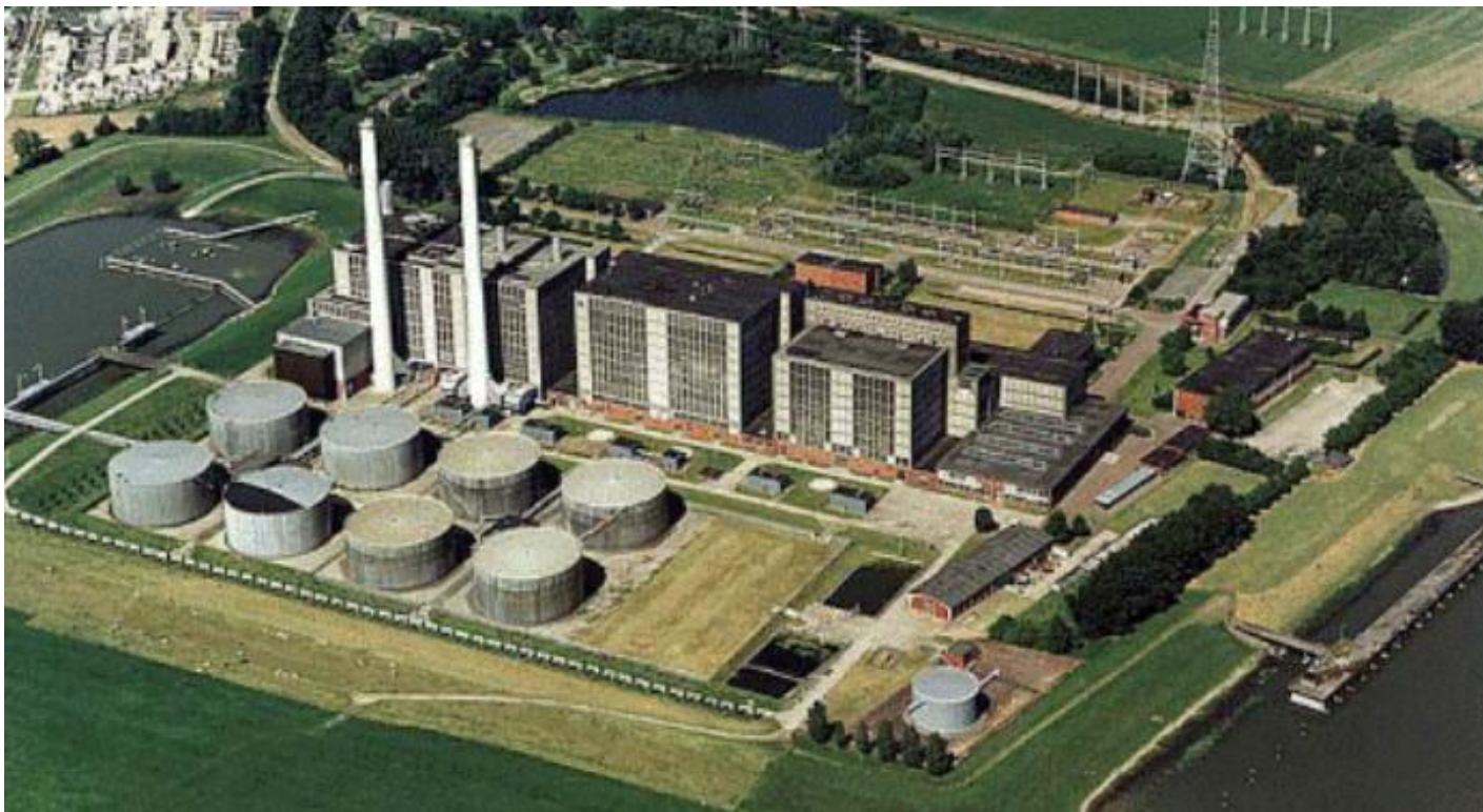
Figuur 3-8 Voormalige IJsselcentrale
