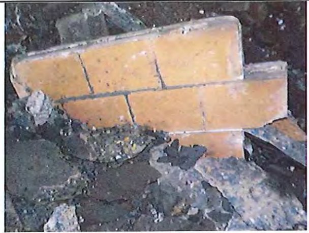
Foto 6. Situatie van het aanwezige vuurvast materiaal met verhoogd stralingsniveau.
