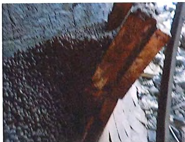
Foto 7. Situatie achter het vuurvast materiaal – hydrokorrels en isolatiemateriaal.
