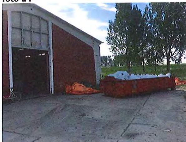
Opslag Buitenloods HC50/HC60
