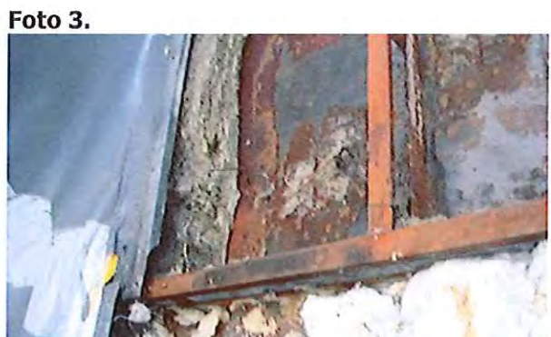
Foto 3. Linkerzijde. Isolatiewolf is verwijderd tot begin van containment
