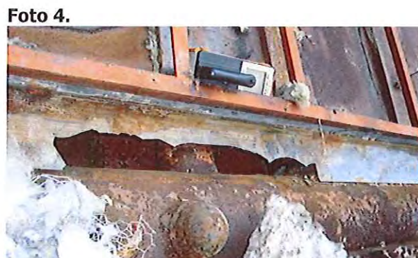
Foto 4. Bovenwand net boven richel met opening
