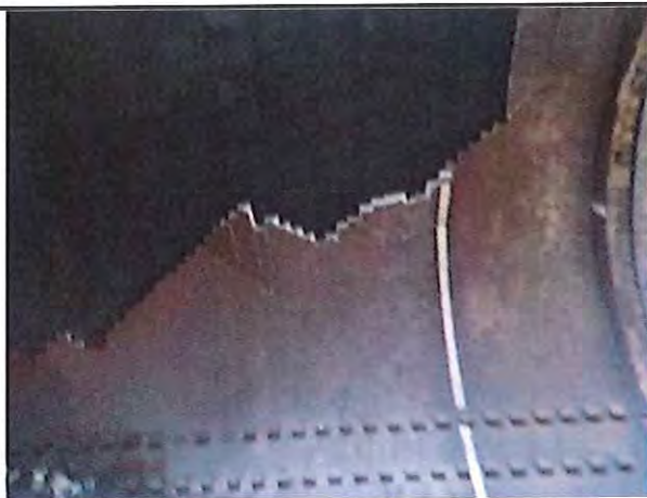
Foto 5. Binnenzijde schoorsteen met verhoogd stralingsniveau.
