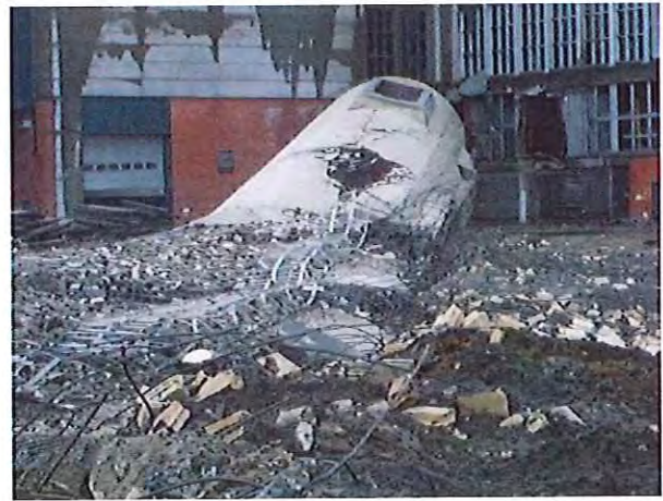
Foto 8. Buitenwand – gewapend beton.
