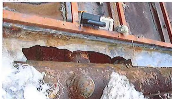
Bovenwand net boven richel met opening
