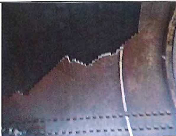
Foto 5. Binnenzijde schoorsteen met verhoogd stralingsniveau.
