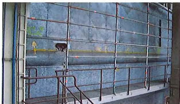
Foto 1. Penthouse: Wand tussen ketel 50 en 4 oude situatie (2017-003)
