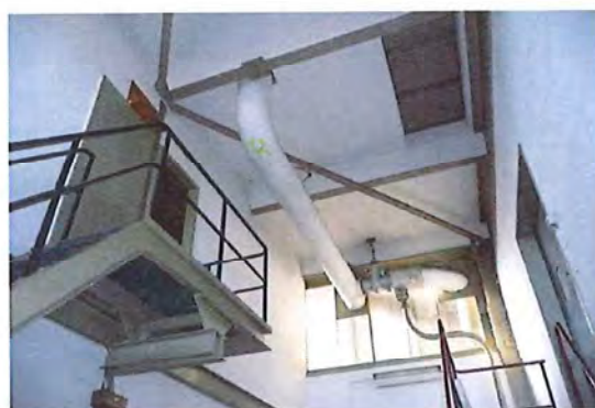
Aan – afvoer gezien vanaf turbine vloer (HC-1)
