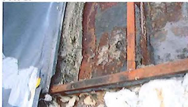
Linkerzijde. Isolatiewolf is verwijderd tot begin van containment
