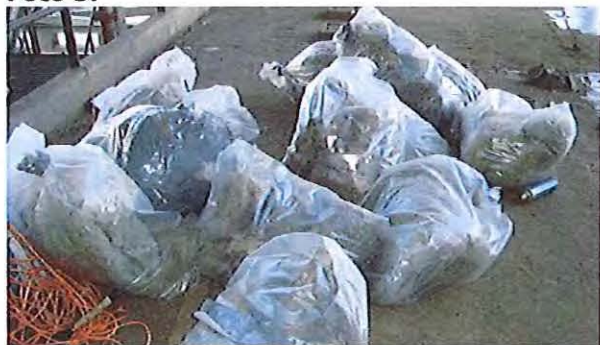
Isolatiewolf van ketelwand wat is uitgesluisd.
