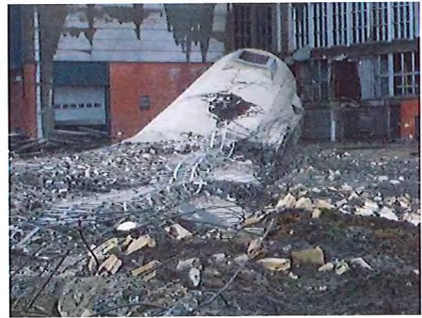
Foto 8. Buitenwand – gewapend beton.
