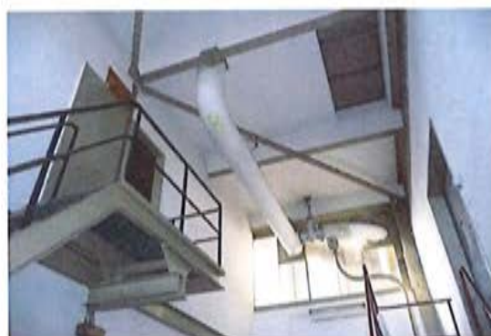
Aan – afvoer gezien vanaf turbine vloer (HC-1)
