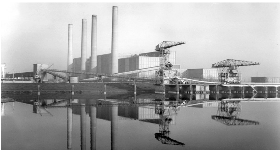
Foto vanuit zuidelijke haven richting fabriek in jaren 70
