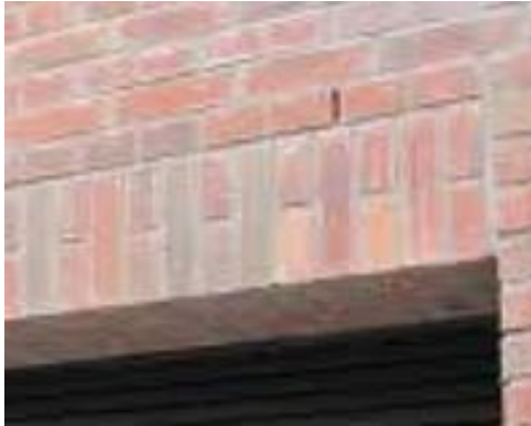
Figuur 6.1 Voorbeeld open stootvoeg of speciale bovengrondse invliegvoorziening voor toegang tot de spouw van de parkeergarage zodat vleermuizen hier gebruik van kunnen maken. Bron: Ecogroen.
