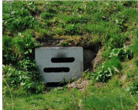
Figuur 6.1 Voorbeeld open stootvoeg of speciale bovengrondse invliegvoorziening voor toegang tot de spouw van de parkeergarage zodat vleermuizen hier gebruik van kunnen maken. Bron: Ecogroen.
