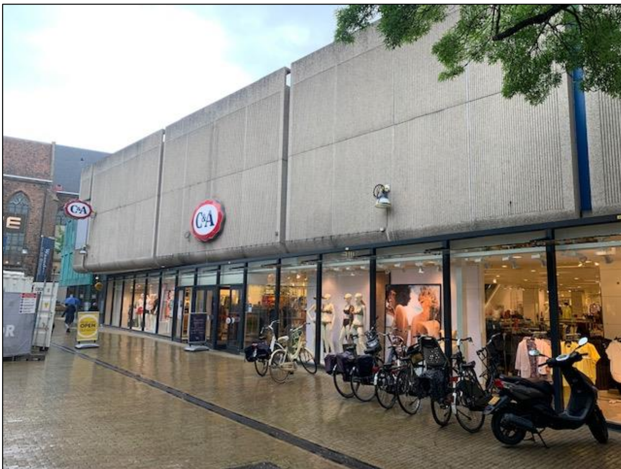
Entree C&A aan de zijde van de Broerenstraat.
