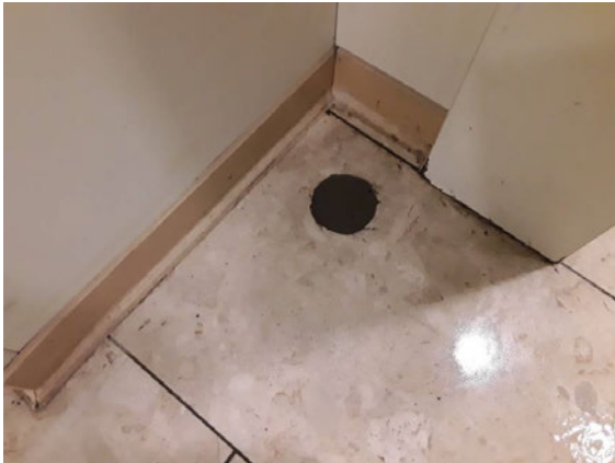
FB02: Alle boorgaten zijn na de werkzaamheden opgevuld met cement
