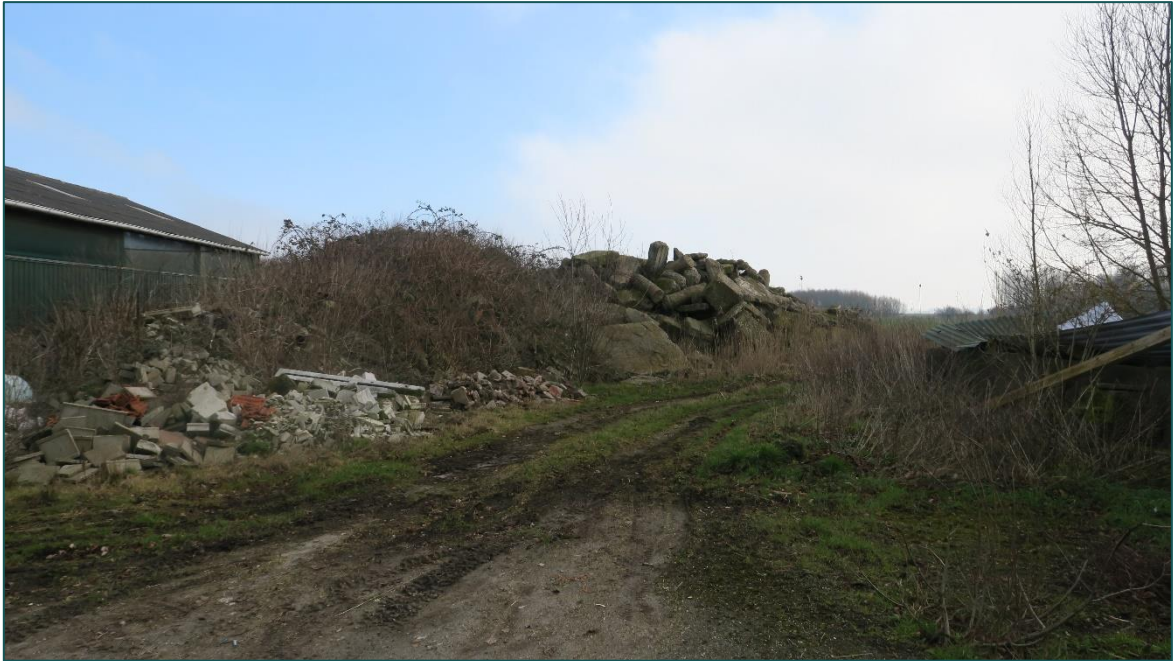
Figuur 3 Op de planlocatie zijn braamstruwelen en een storthoop met betonnen stukken gesitueerd.
