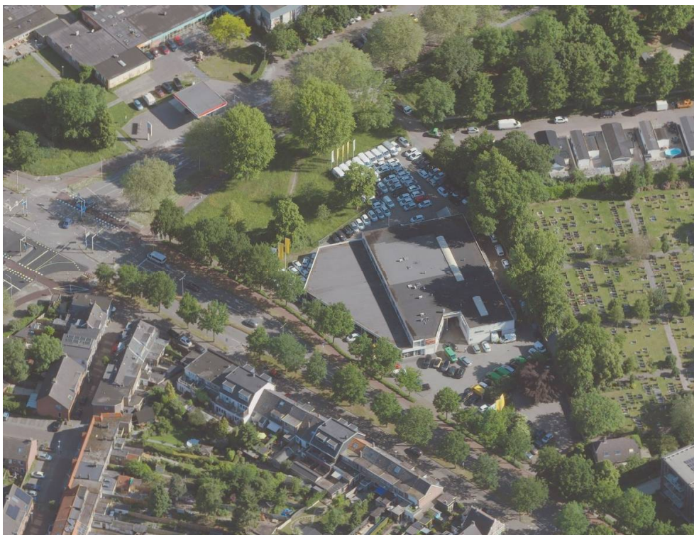
Luchtfoto (vogelvlucht) met garage Oving centraal in het projectgebied.
