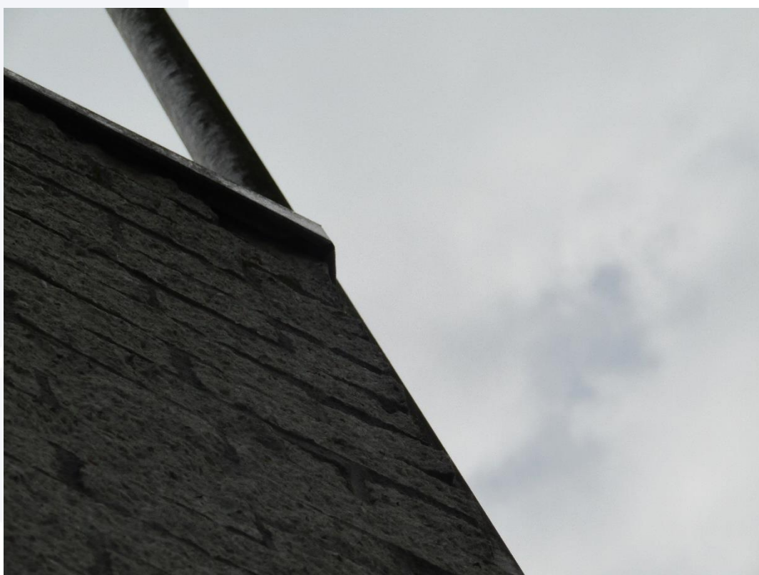
Foto 6. Ruimte tussen dakrant en bakstenen muur.
