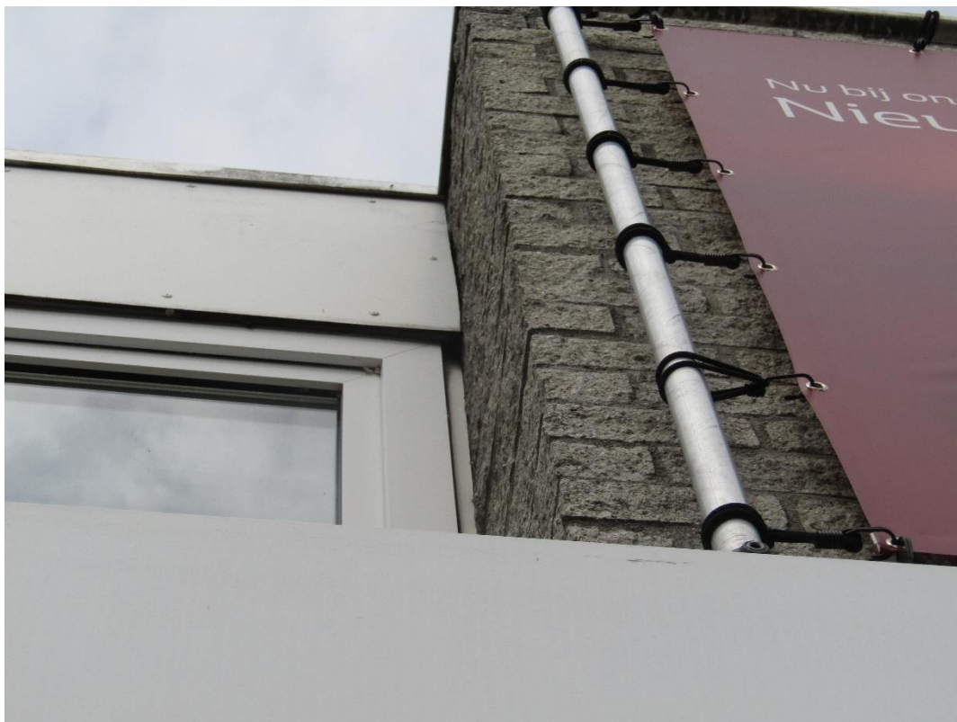
Foto 5. Ruimte tussen dakrant en bakstenen muur.
