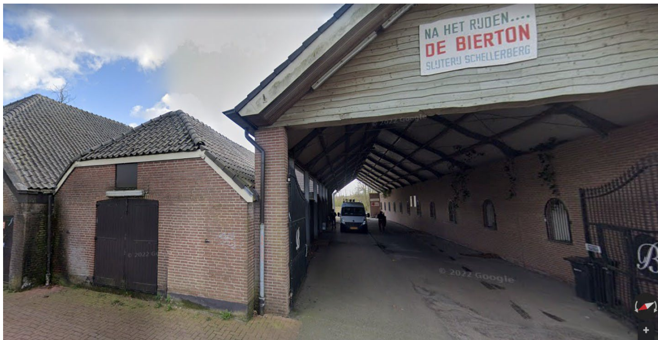
Afbeelding 3.2 Afbeelding locatie waar balts- en antikgedrag is waargenomen. De overkapping (rechts) betreft een dichte kolom met stalen frame en houtwerk. Hierin zijn geen geschikte openingen gevonden. Het is daarmee aannemelijk dat de soort in het monumentale gebouw (links) zit.
