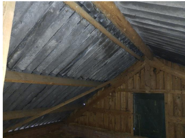
Afbeelding 3. Weergave van de daken van de jongveestal en melkveestal met asbesthoudende platen in de daken.
