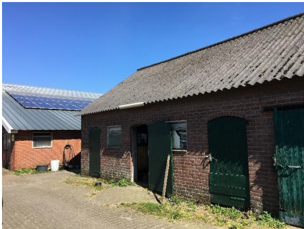
Afbeelding 3. Weergave van de daken van de jongveestal en melkveestal met asbesthoudende platen in de daken.
