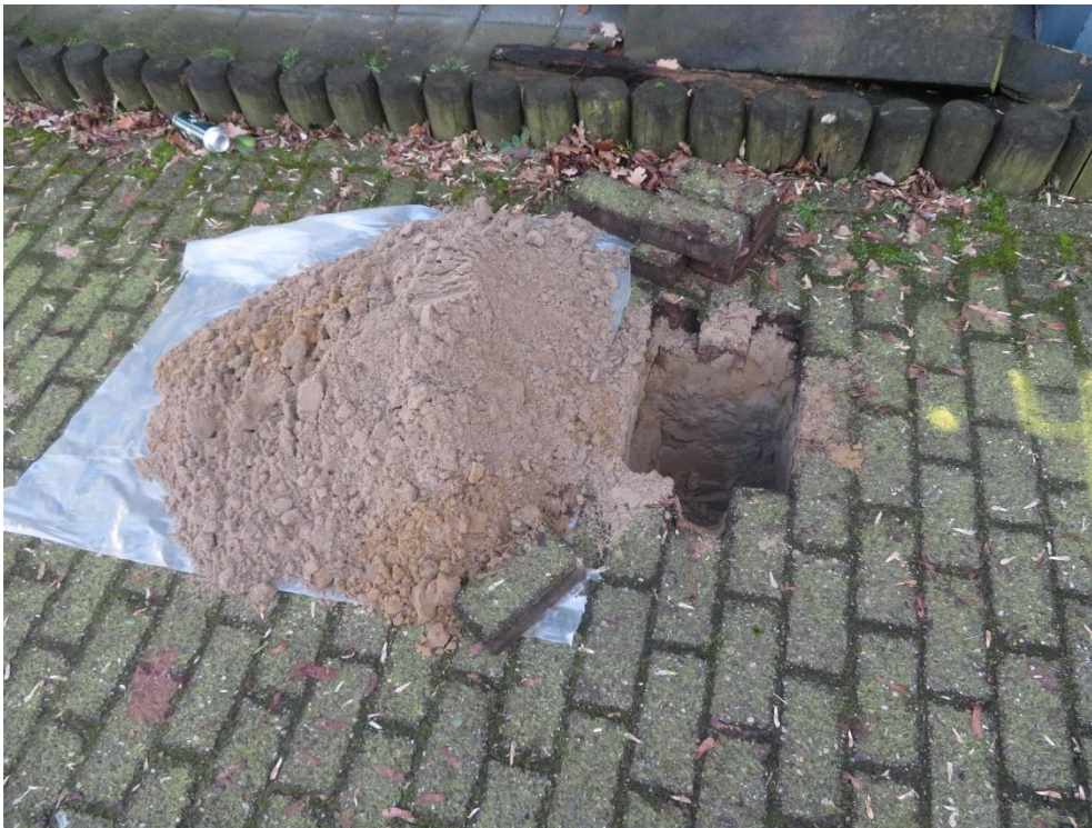
Foto 1: Opgegraven materiaal ter hoogte van asbestinspectiegat 4
