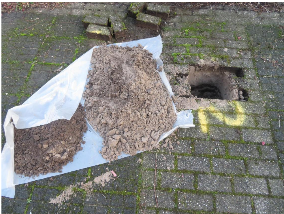
Foto 2: Opgegraven materiaal ter hoogte van asbestinspectiegat 2
