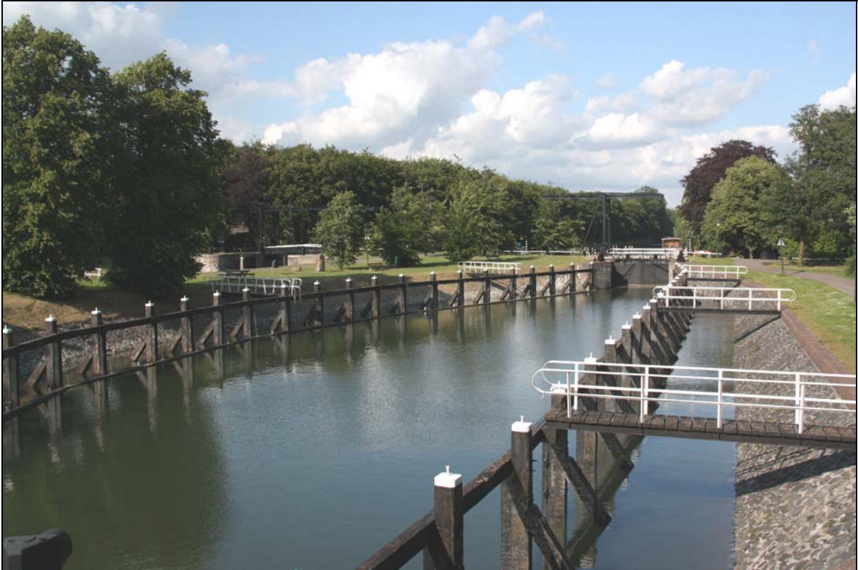
Sluiskom van de oude sluis bij Katerveer
