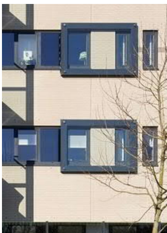
Figuur 4.1 Foto van metaglas.nl van het Silent-Air-systeem (glas met zwarte omranding) naast ramen zonder Silent-Air Systeem.
