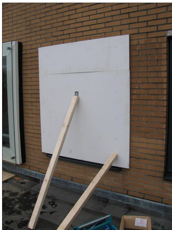
Foto II.4 Provisorische afdichting tweede raam
