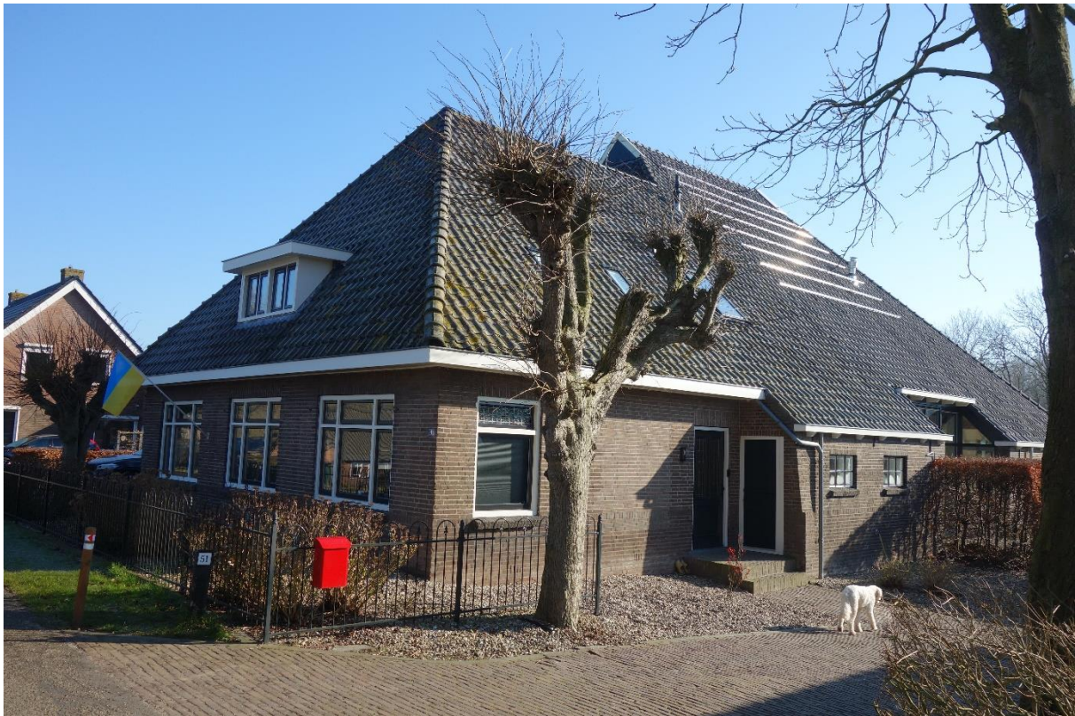
Voorgevel en rechter zijgevel.
