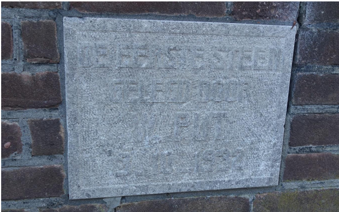
Gewelsteen in de voorgevel.
